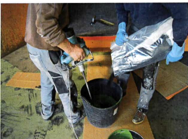
Sous agitation, rajouter le sable et Le caoutchouc
