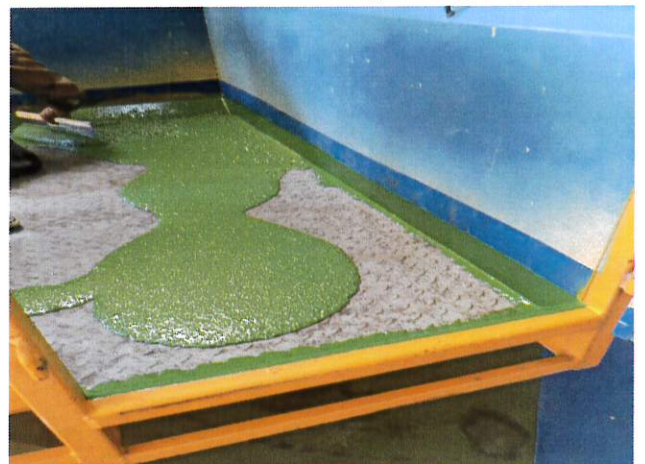
Vider sur la surface à traiter et Étaler
