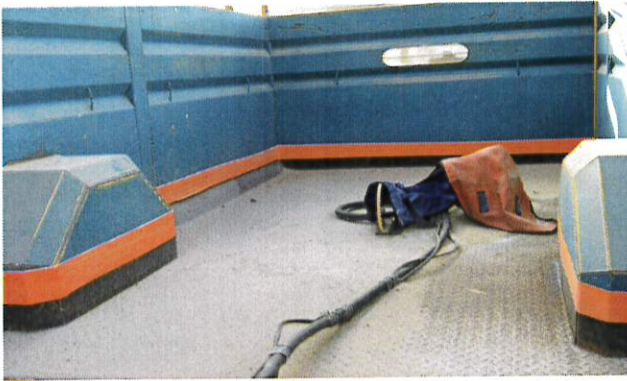
Première étape : sablage de la surface à recouvrir
