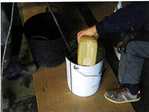
Vider la totalité du durcisseur dans le seau de résine
