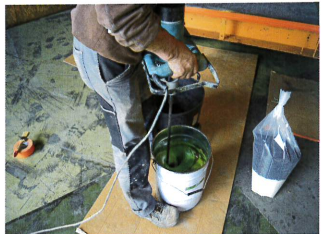
Bien mélanger avant de transvaser Dans un contenant plus grand
